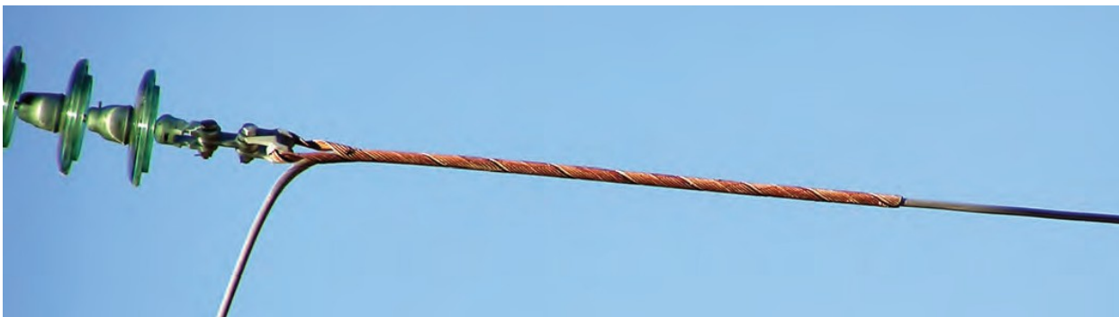
Рисунок 15. Натяжной зажим спирального типа производства ЗАО «Электросетьстройпроект».
